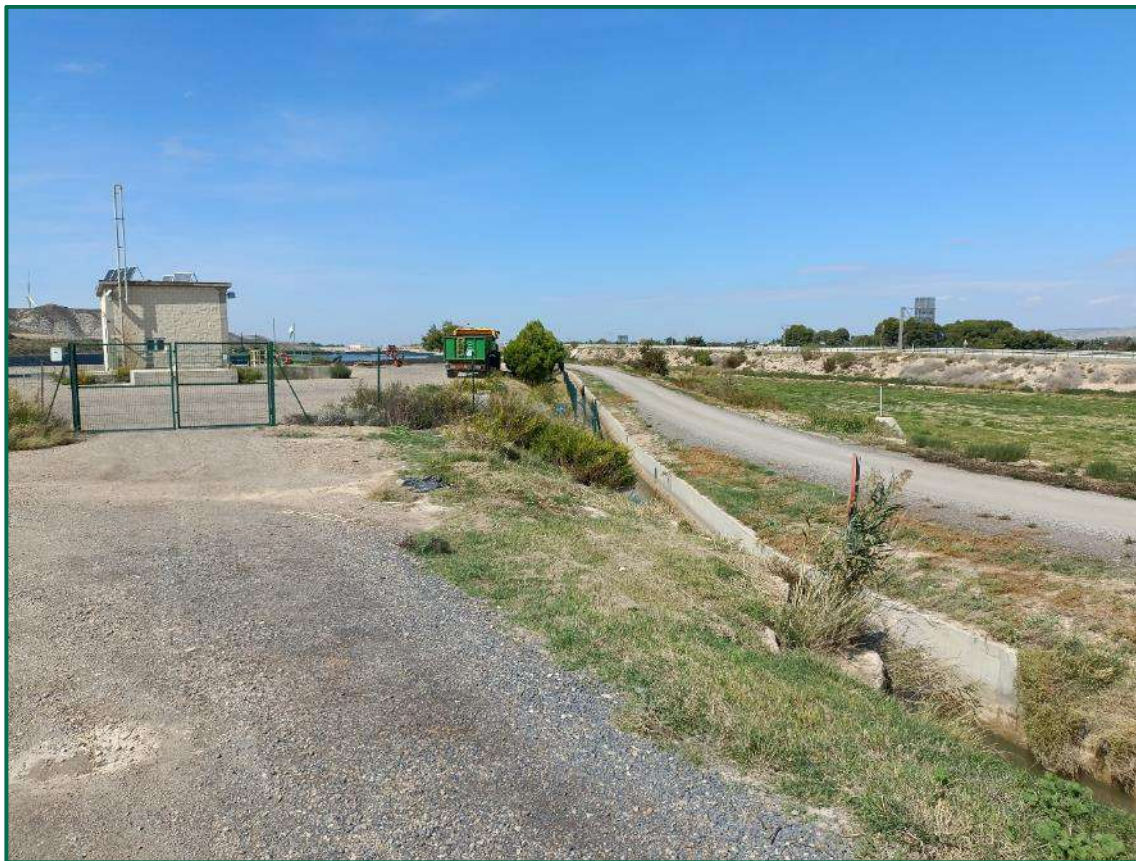
Fotografía 1. Detalle del cruce de la línea soterrada sobre el Canal Imperial de Aragón.
