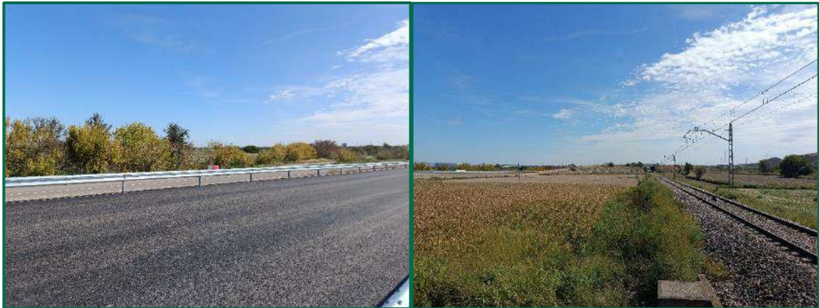
Fotografía 13. Detalle de los cruces de carretera y ferrocarril donde hay pies dispersos y vegetación arvense, que será eliminada para la zanja y posteriormente se restaurará.
